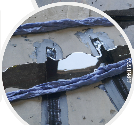
Intervention sur l'avant: fissures
